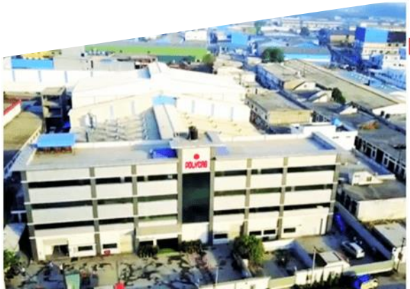
Fan Manufacturing Unit
